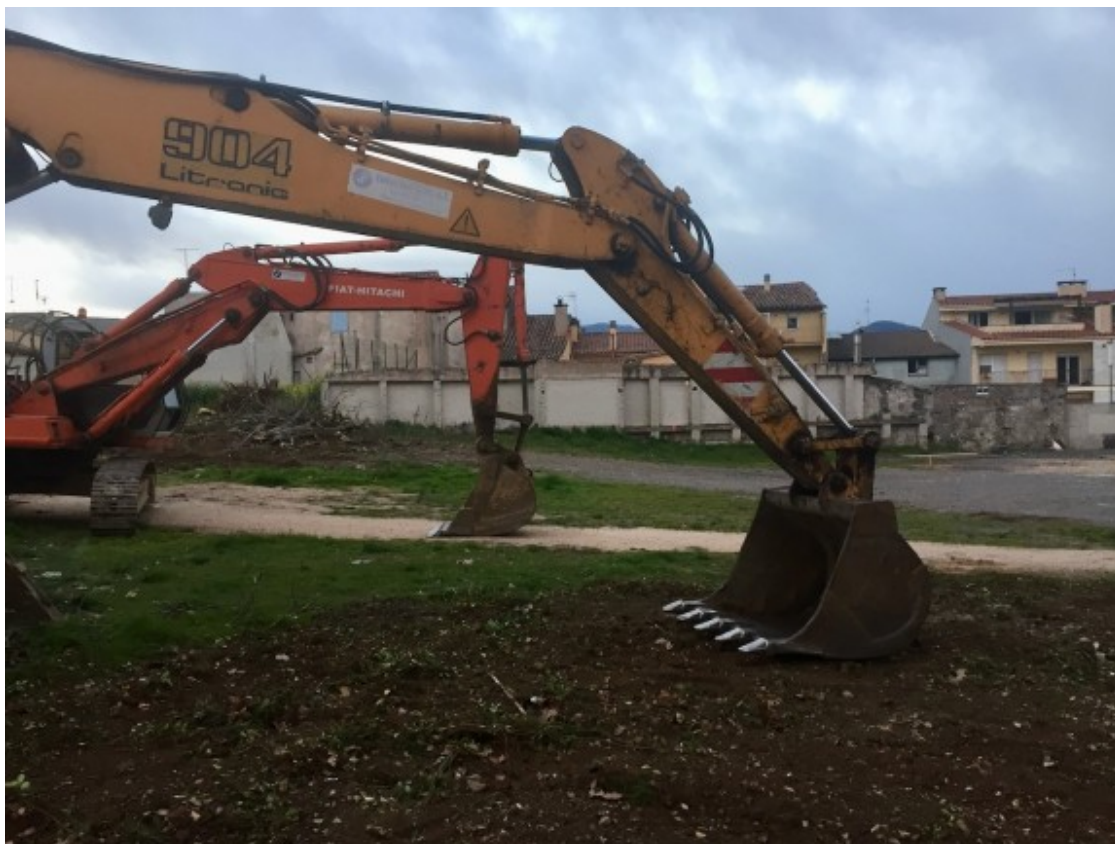
Dues excavadores de grans dimensions a l'inici de les obres del futur Espai Cràter. Foto: Xavier Borràs.
