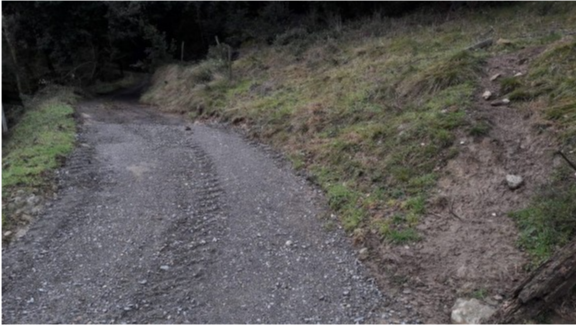
Un altre aspecte de l'arranjament de la carretera a Puigpardines. Foto: @ajuntamentbas.
