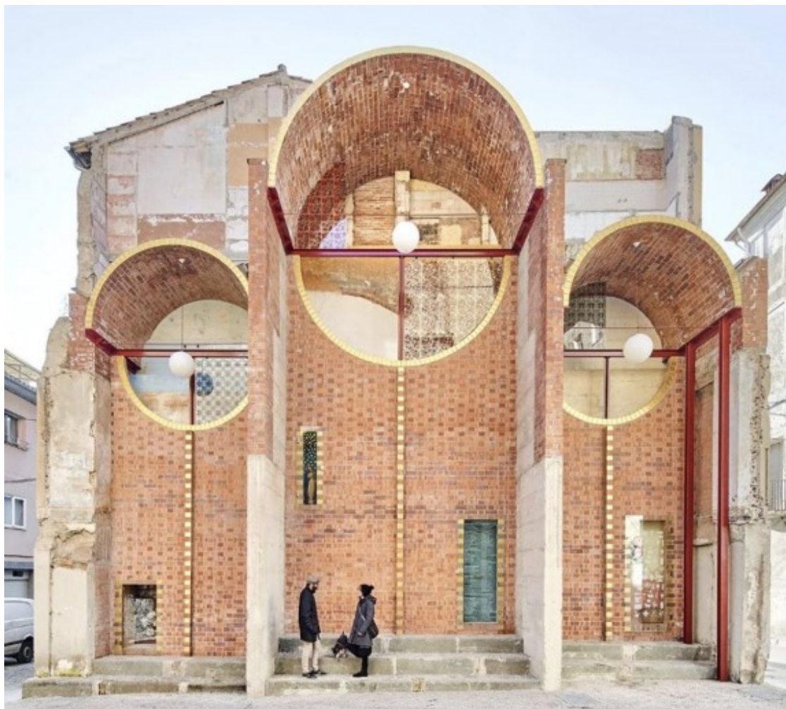
La mitgera de Can Sau, d'unparelldarquitectes. Foto: @unparelldarquitectes.
