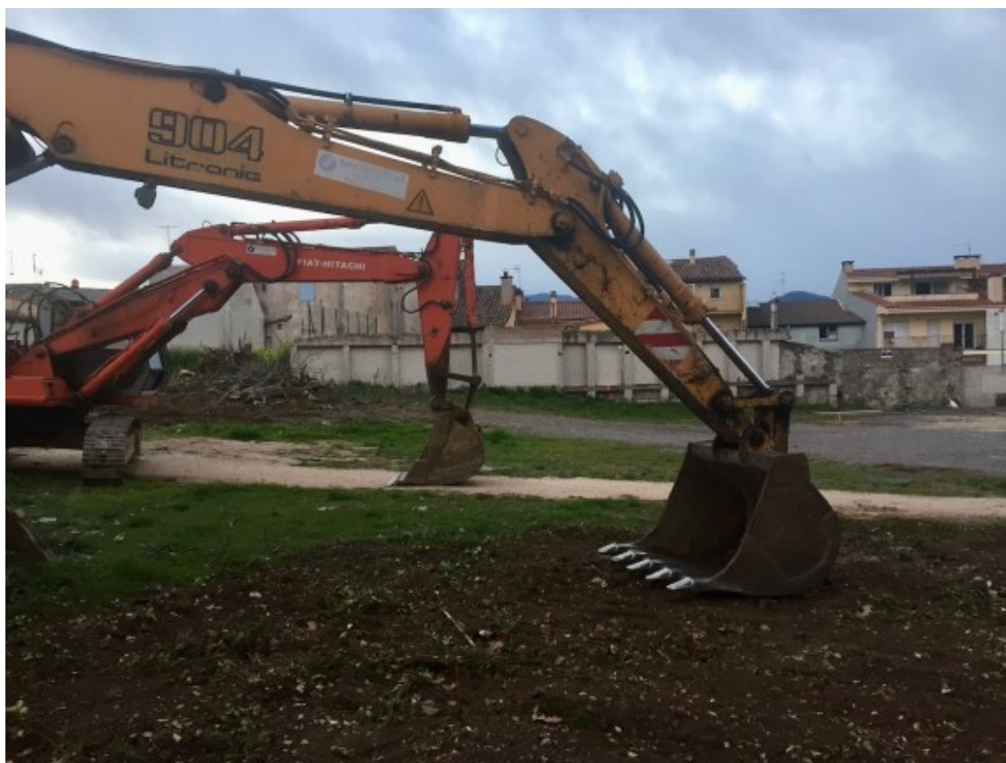
Dues excavadores de grans dimensions remouen la terra del futur Espai Cràter. Foto: Xavier Borràs.
