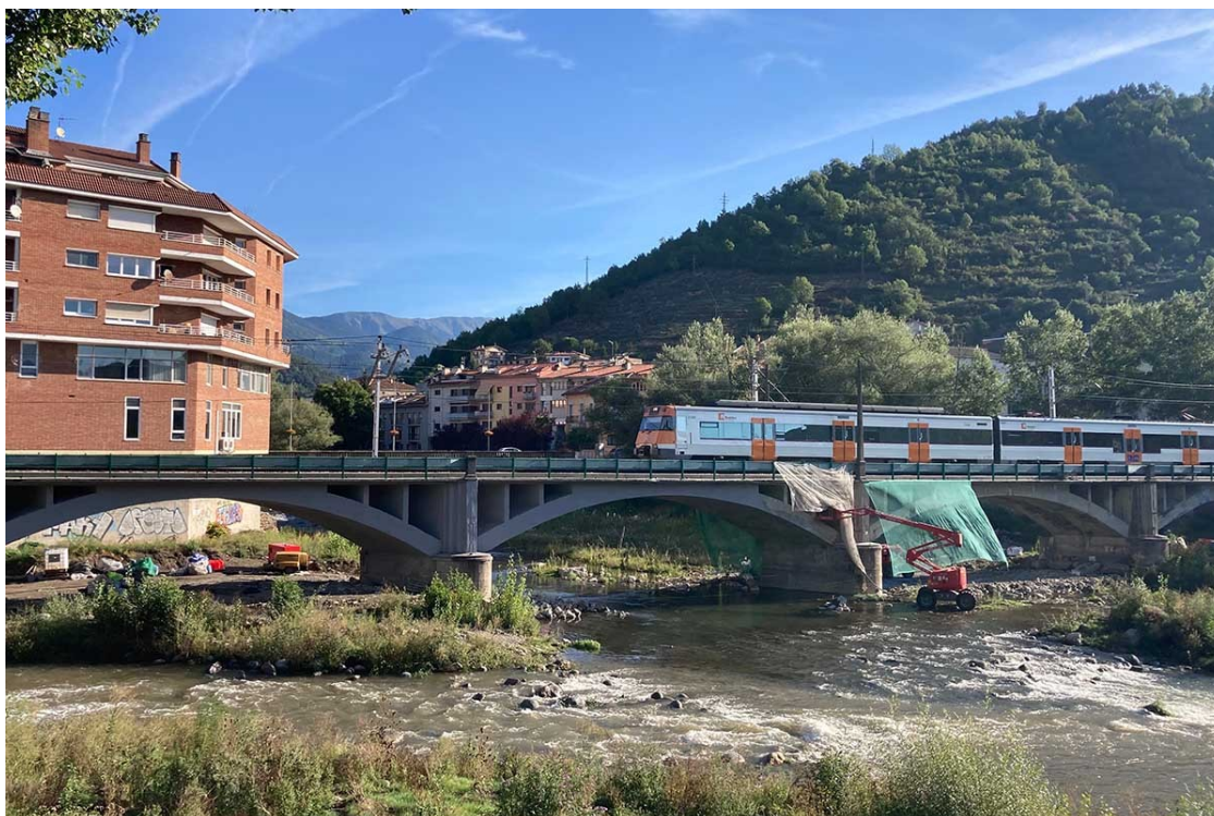
Un tren de l'R3 tornant a passar pel pont de Ripoll | ACN
