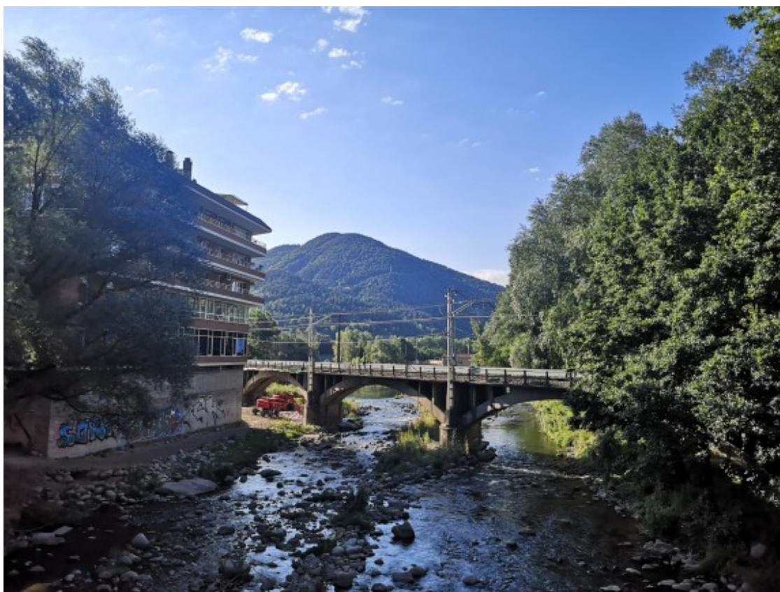
El pont del tren de Ripoll Foto: Arnau Urgell
