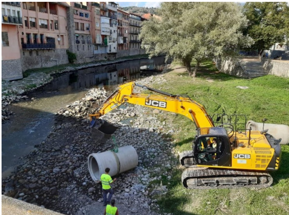
Les obres al riu Ter | Ajuntament de Ripoll
