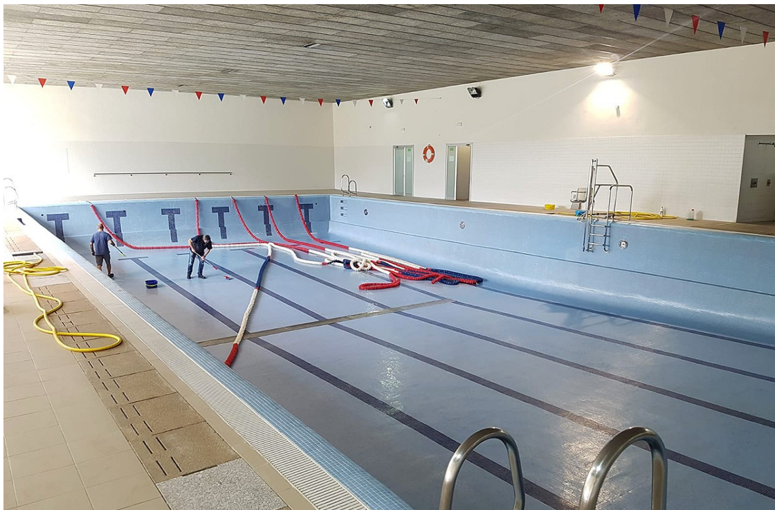
Obres de manteniment a la piscina municipal de Ripoll | Aj. Ripoll
