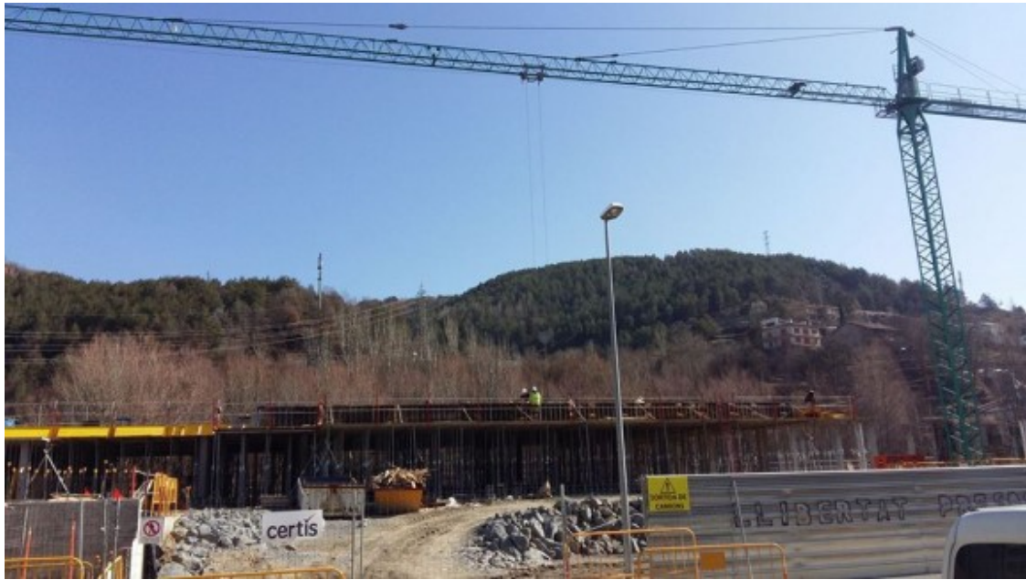
Les obres de la nova escola de Campdevànol van vent en popa i ja s'està construint el segon pis Foto: Isaac Muntadas
