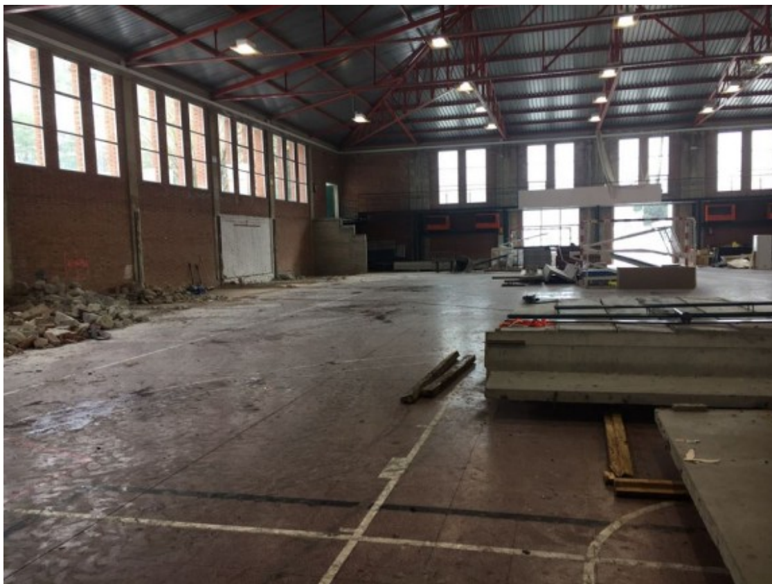
La grada del pavelló Mercè Guix que dóna a la banda del tennis ja ha estat enderrocada Foto: Joan Manso
