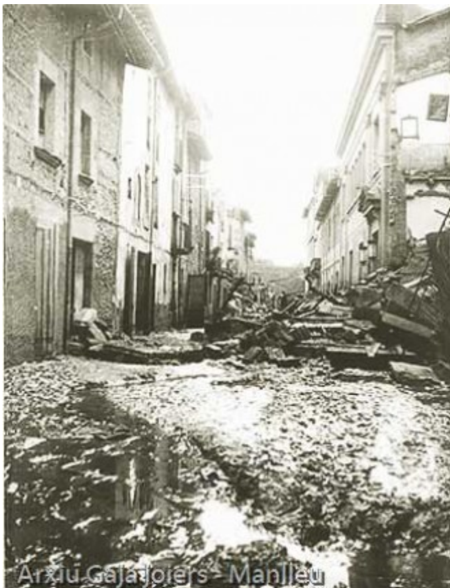
Detall del carrer Enric Delaris de Manlleu, a primer terme a la dreta i al costat del Patronat de Cultura podem contemplar un edifici caigut per culpa de l'aiguat, el 20 d'octubre. Foto: Jaume Gaja (Arxiu Gaja Joiers. Manlleu)
