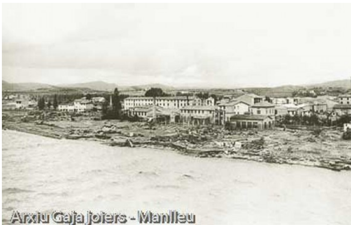
Vistes generals de les destrosses de la fàbrica S.A. Serra ocasionades per l'aiguat, el 19 d'octubre. Foto: Jaume Gaja (Arxiu Gaja Joiers. Manlleu)
