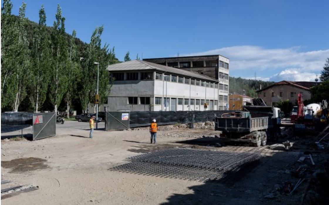
Solar on Comforsa construirà la nova premsa. Foto: Adrià Costa
