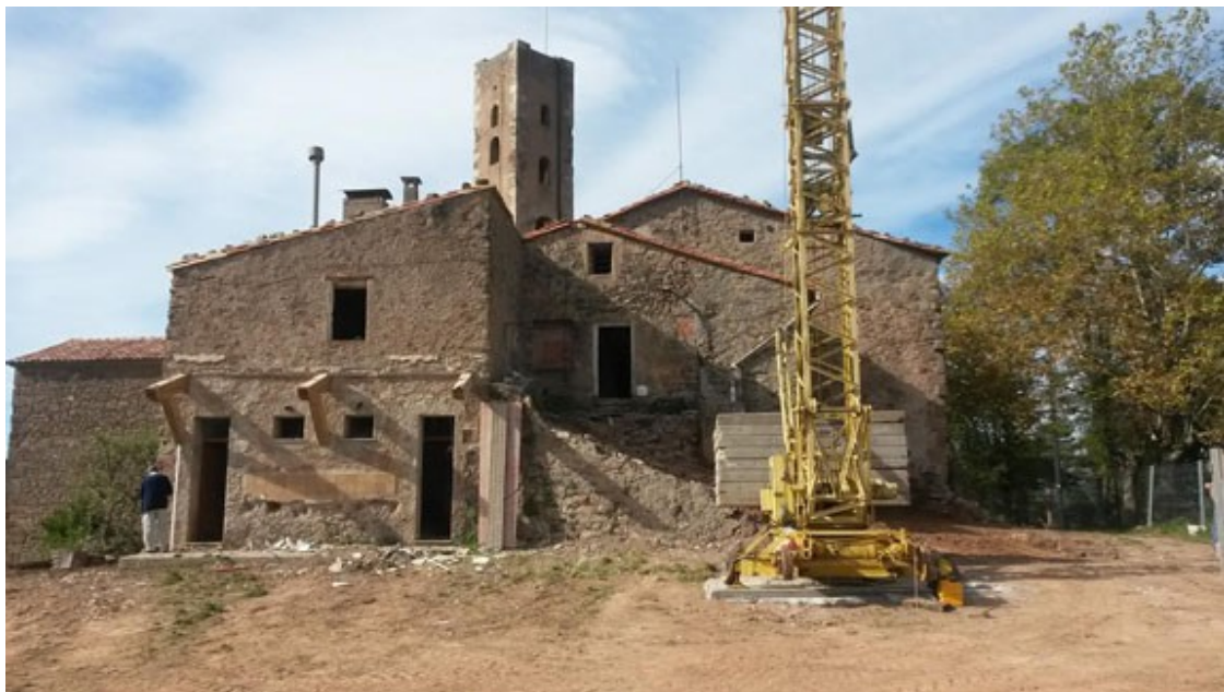
Obres a la masia de Sant Antoni de Pàdua. Foto: Ajuntament de Sant Joan de les Abadesses
