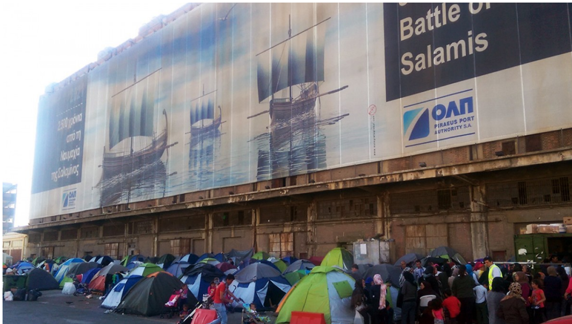
Exterior de la terminal e2 | Isaac Besora.
