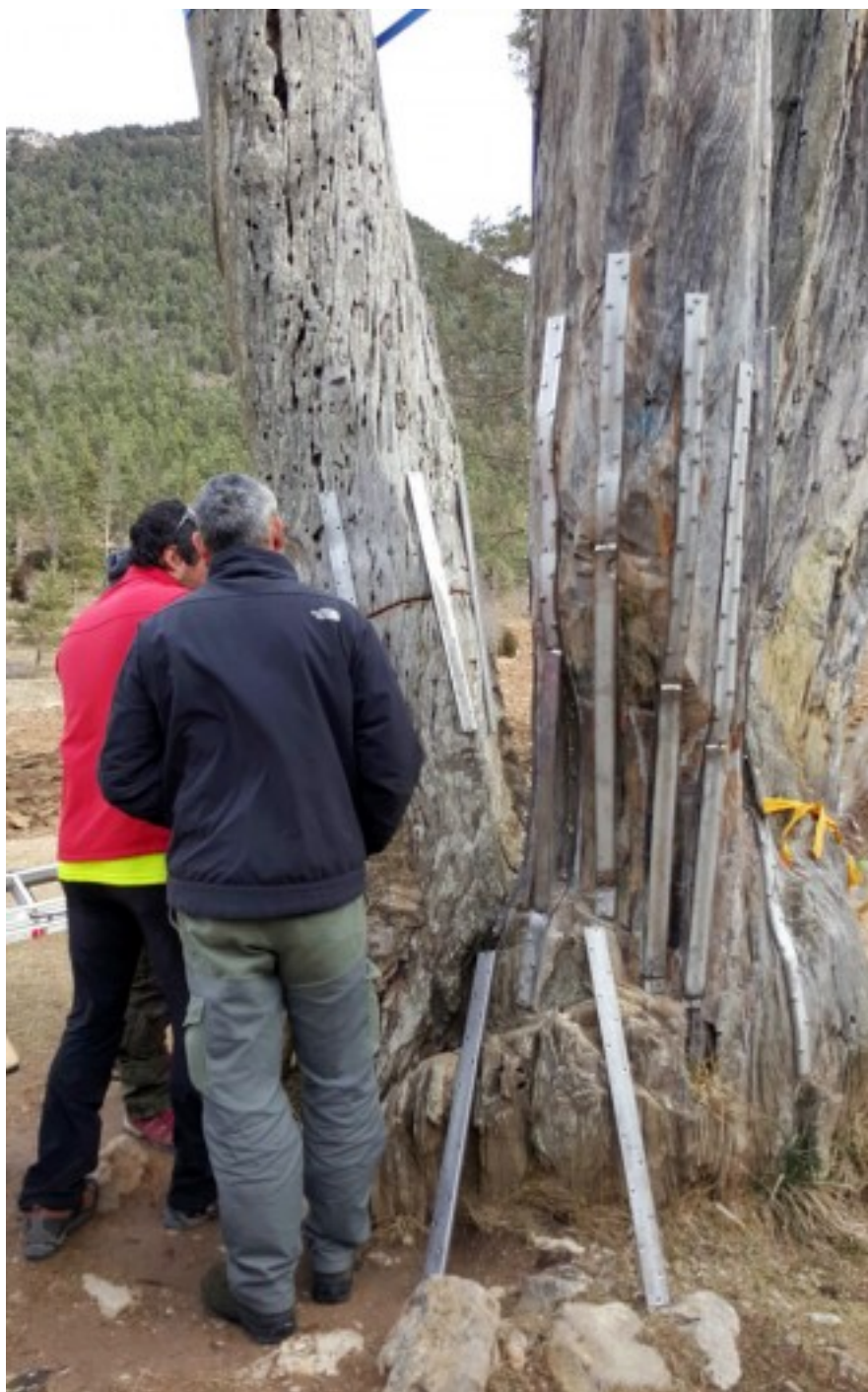
Col·locant els ferros al voltant de la branca tallada. Foto: Ramon Burniol
