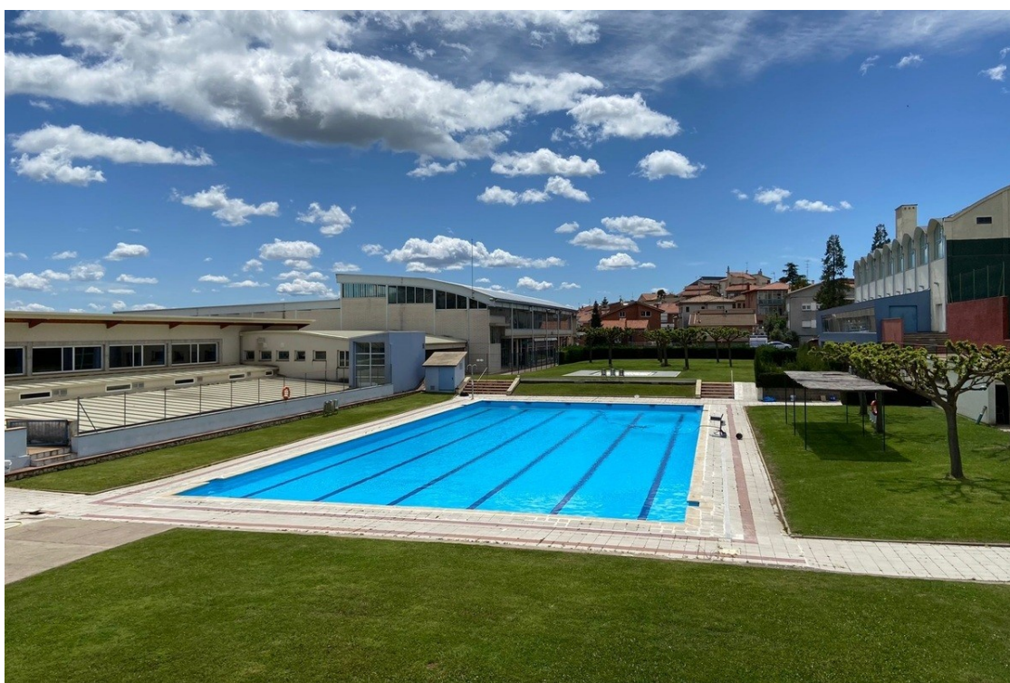
Piscina municipal de Berga. | Ajuntament de Berga
