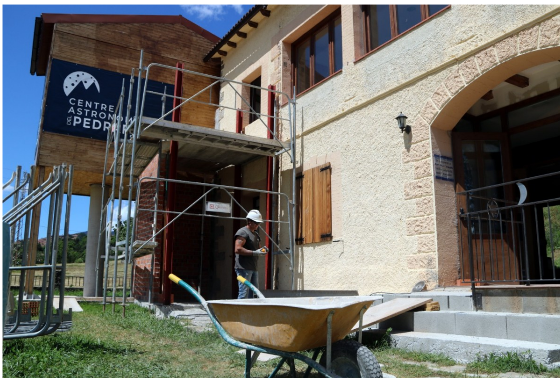
Operari treballant en la rehabilitació d'un habitatge a Saldes | ACN
