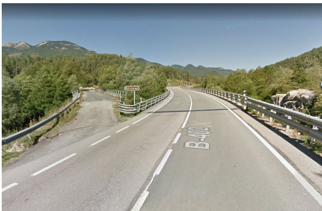
Punt de la B-402 on s'efectuaran les obres | Consell Comarcal del Berguedà
