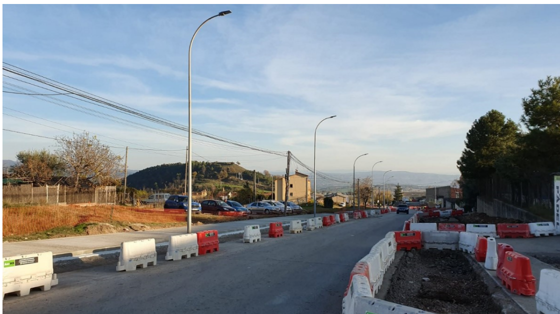
Fotos de les obres de modernització al Polígon de la Valldan. | Serveis Tècnics
