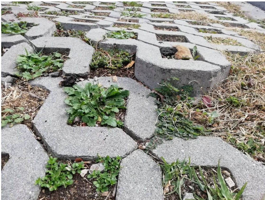
Llambordes sobreposades al parc de les Aubes. | Cedida
