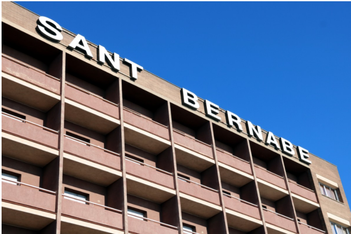
Façana de l'Hospital Sant Bernabé. | ACN
