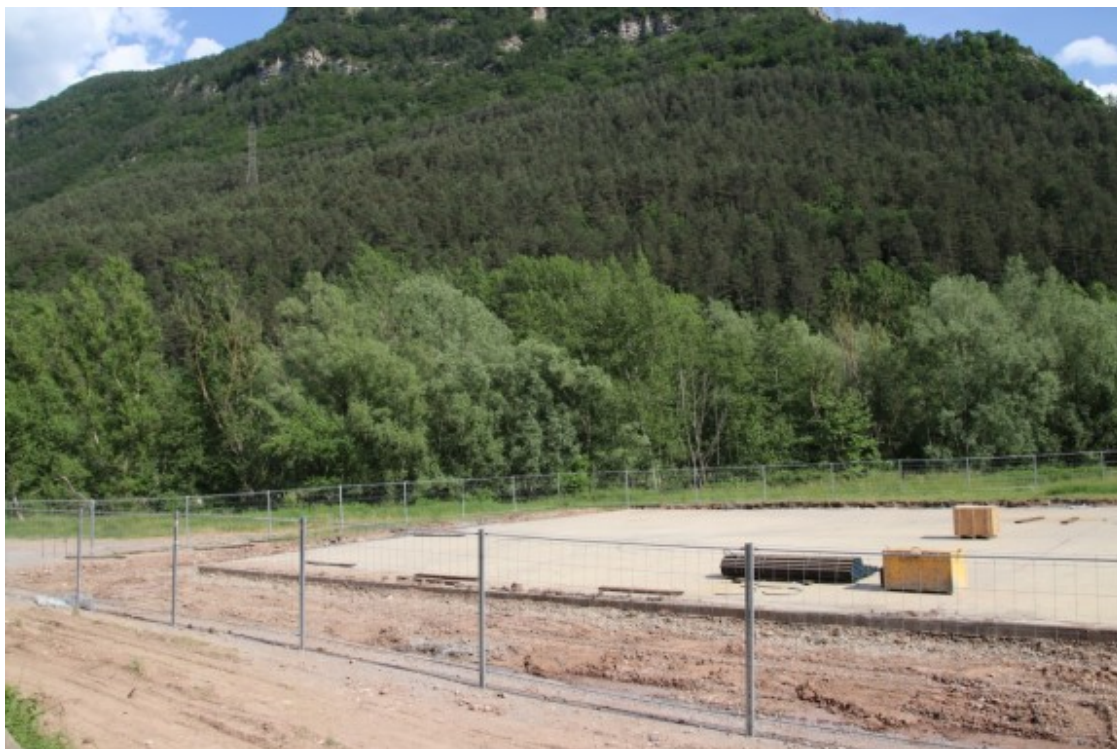
Treballs de construcció de la sala polivalent, avui. Foto: Axel Lapuerta
