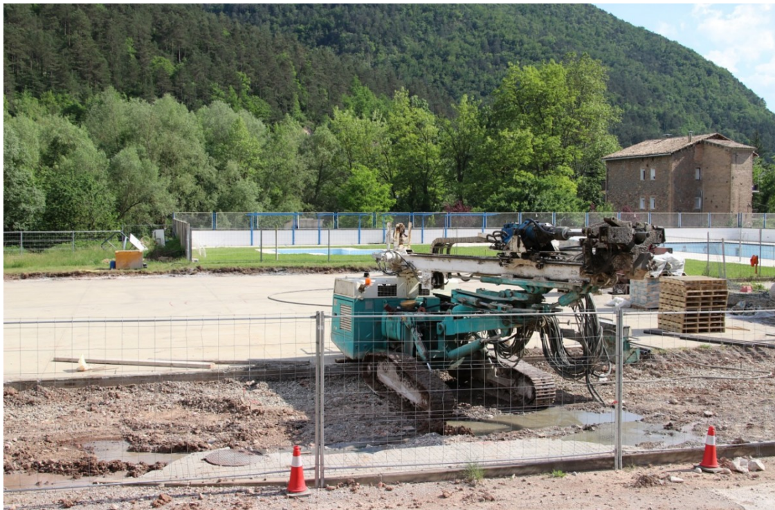
Treballs de construcció de la sala polivalent, avui. | Axel Lapuerta
