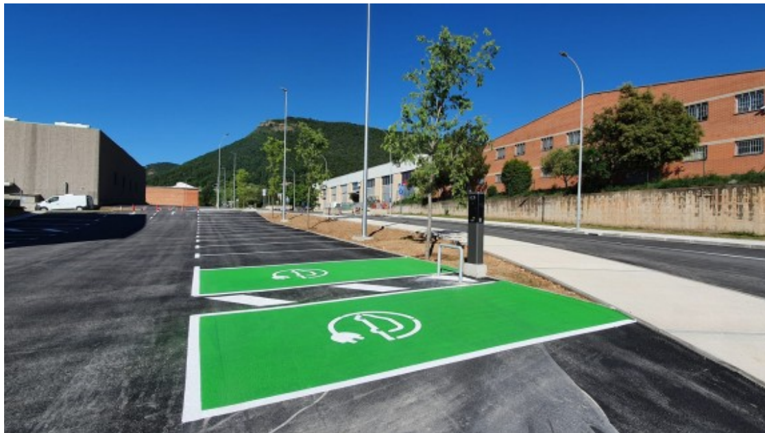
Places d'aparcament per a la recàrrega de vehicles elèctrics. Foto: Aleix Serra / Aj. Berga
