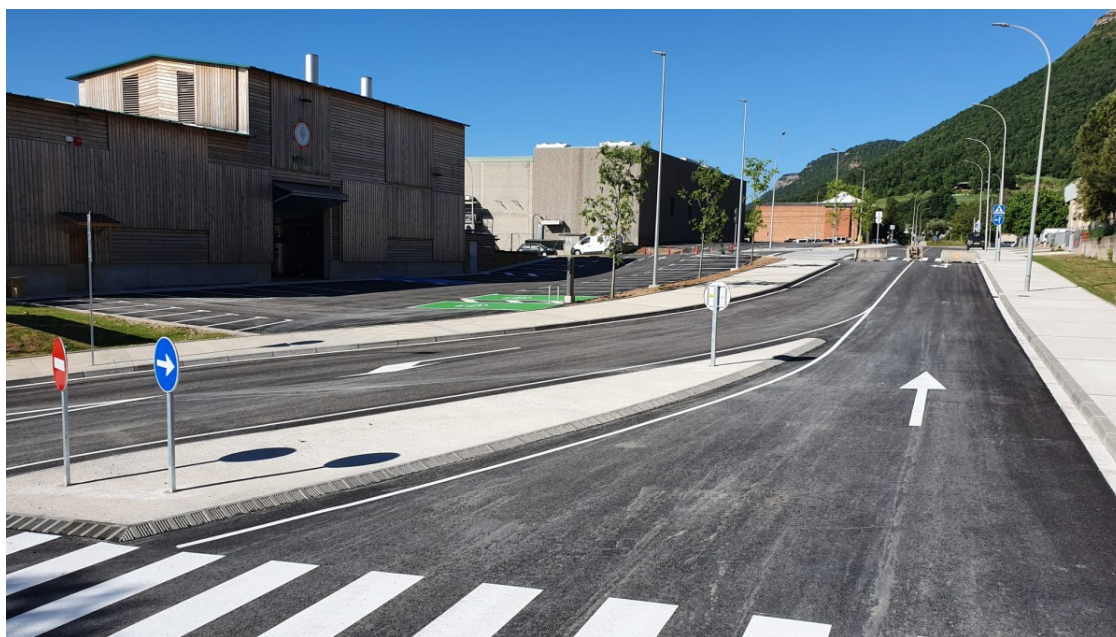
Finalització de les obres al Camí de Can Ballús. | Aleix Serra / Aj. Berga
