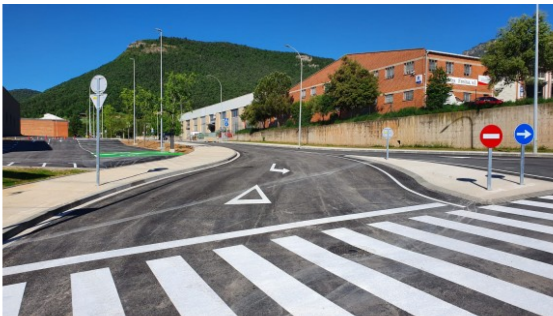
Finalització de les obres al Camí de Can Ballús, al Polígon de la Valldan. Foto: Aleix Serra / Aj. Berga
