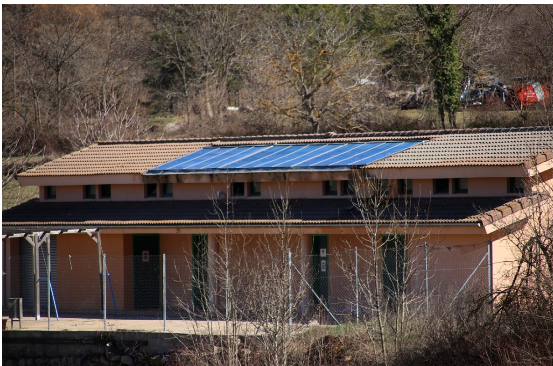
Plaques fotovoltaiques a la piscina municipal de Sant Julià de Cerdanyola | Axel Lapuerta
