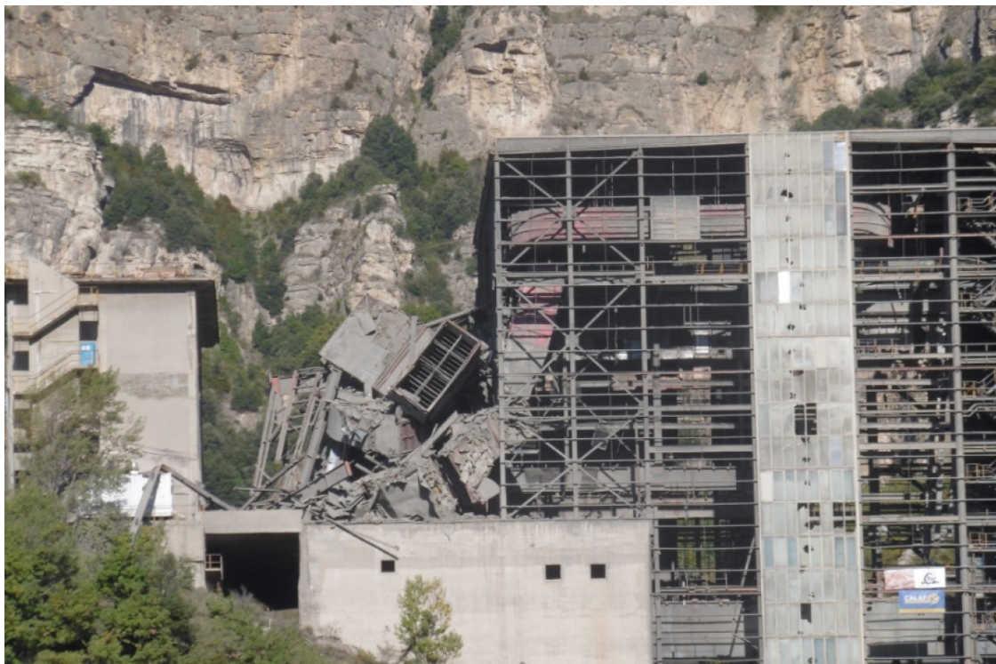
Un dels edificis que s'estava desballestant. | Cedida
