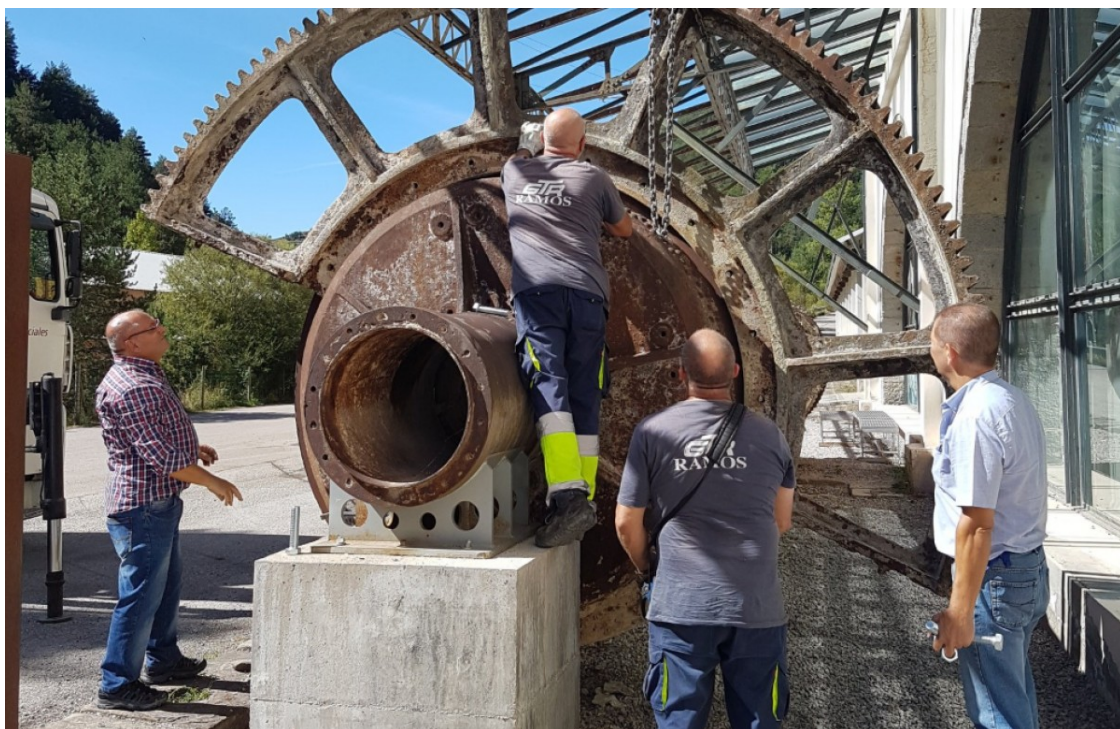
Instal·lació de la peça | Museu del Ciment
