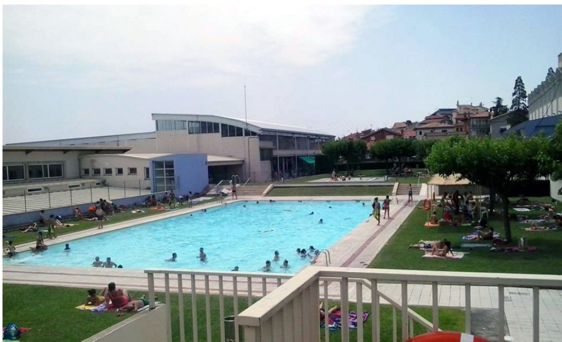
Piscina Municipal de Berga.
