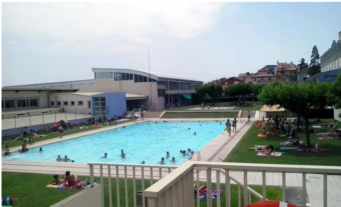
Piscina Municipal de Berga.
