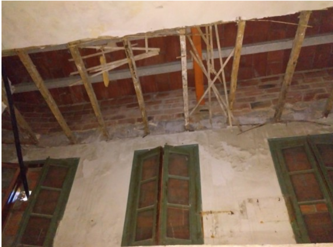
Estat actual de l'hostatgeria de Queralt. Foto: Decidim Berga
