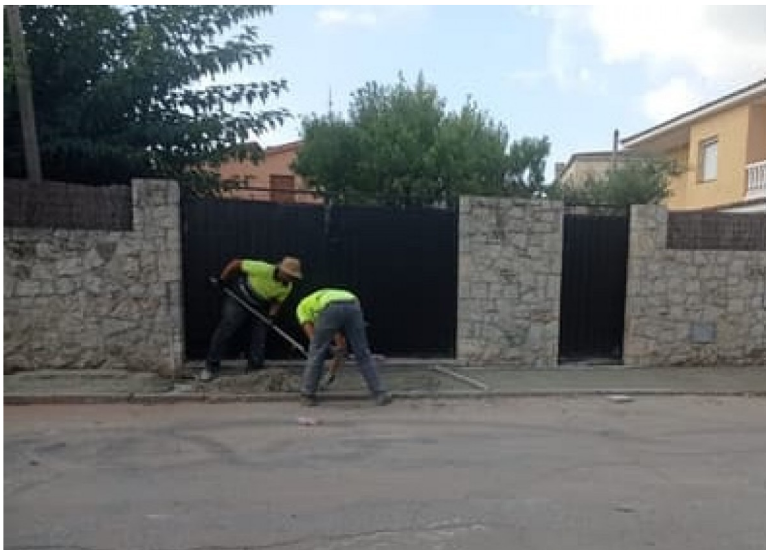
Obres a les voreres | ASO
