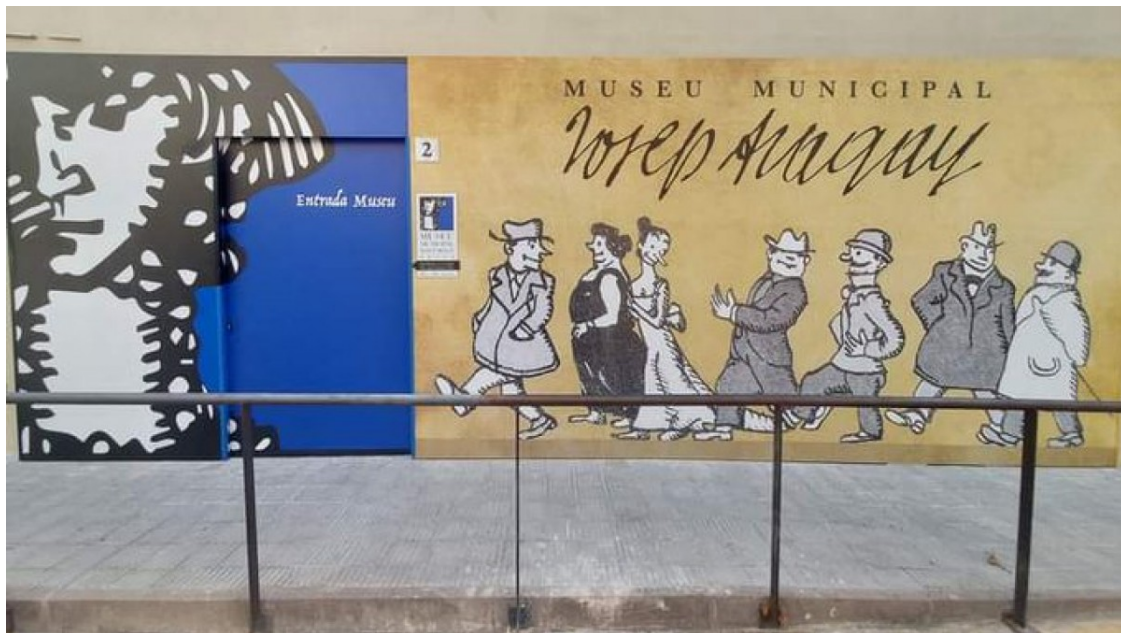
Imatge de la façana rehabilitada del Museu Municipal Josep Aragay | Ajuntament Breda
