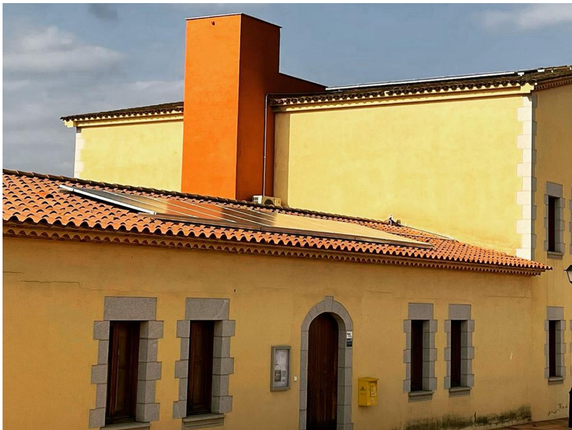
Edifici de l'Ajuntament de Sant Feliu de Buixalleu | Aj Sant Feliu de Buixalleu
