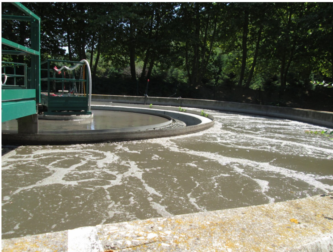
Estació Depuradora d'Aigües Residuals de Vallgorguina | Consorci Besós Tordera
