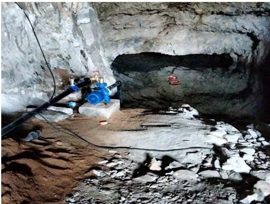
Bomba impulsora a l'interior de la mina de Xauxa per millorar la captació d'aigua potable a Gualba | Gualba.cat
