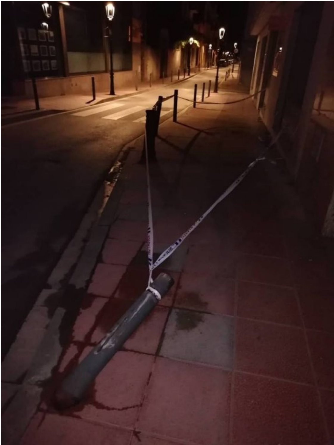
Una piona de la Carretera Vella de Sant Celoni malmesa per un accident de trànsit
